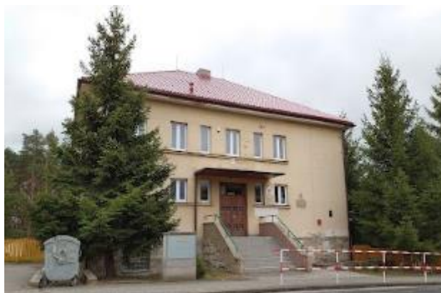
Obrázek 10: ZŠ a MŠ Jestřebí - budova ZŠ v Provodíně
