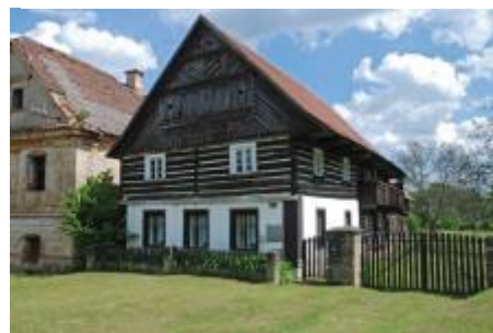
Obrázek 29: Dům, Pavlovice č.p. 38
