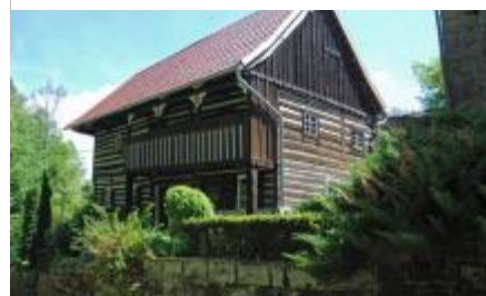
Obrázek 28: Dům, Pavlovice č.p. 28
