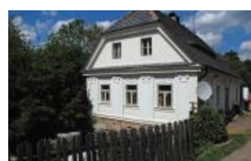
Obrázek 32: Dům, Pavlovice č.p. 27
