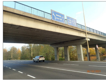
POZOR!!! OSEK SILNICE II/262 POD MOSTEM BYL V ROCE 2021 OPRAVEN
