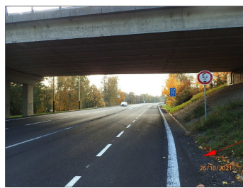
POZOR!!! OSEK SILNICE II/262 POD MOSTEM BYL V ROCE 2021 OPRAVEN
